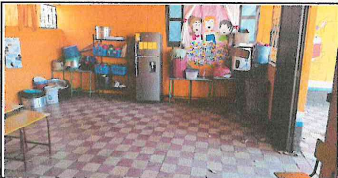
Foto 1: Cambio de piso del Aula 1
