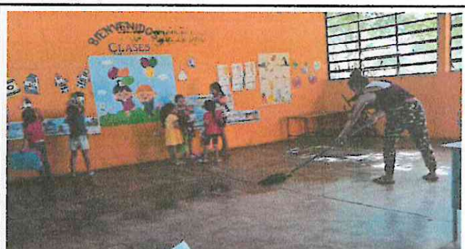
Foto 4: Cambio de Piso del aula 3
