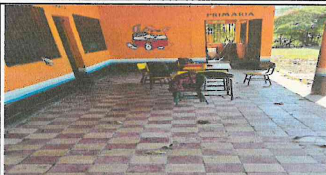
Foto 2: Cambio de piso del corredor del aula 1 y aula 2
