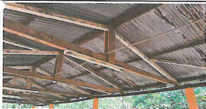
Foto 5: Cambio de Lámina y Costanera a la Galera
